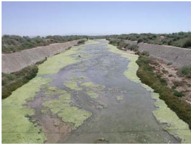
Canal drainant des eaux usées vers la lagune de Nador
