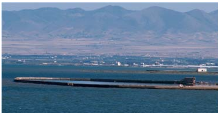
Système de traitement des eaux usées par lagunage installé à Nador (Rapport COED, 2006)
