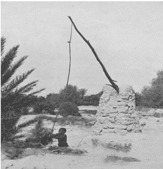
Photo.2. Puits à balancier.
