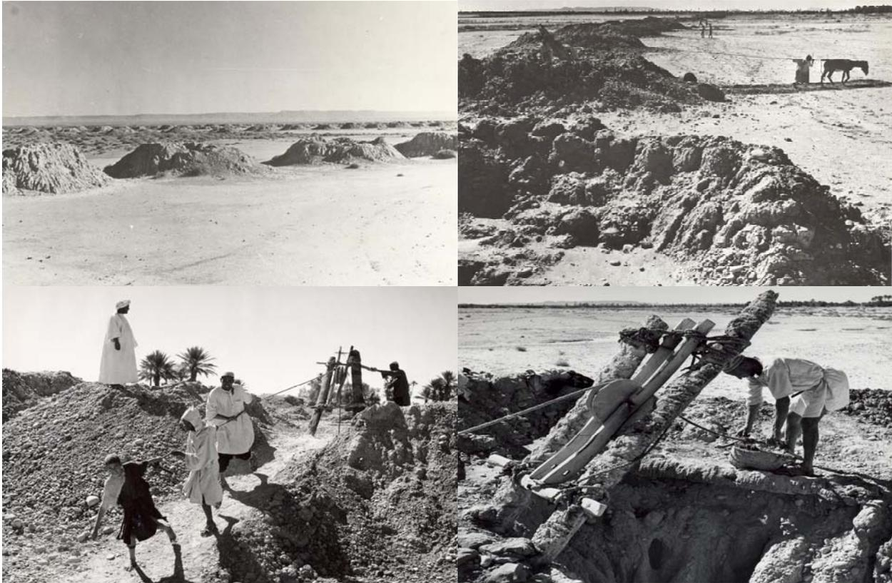
**Photo . 5.** Vue sur les khattaras amenant l'eau aux palmeraies et phase de curage par des ouvriers. Les matériaux extraits de la galerie forment un niveau constant. (clichés 1949, in Margat. 1962).
