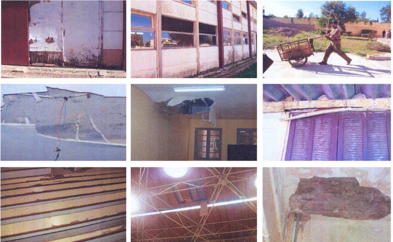
Construite intégralement en dure, la faculté des sciences Dhar Mehrnaz souffre pour sa part, de l'existence dans ses bâtiments de grandes fissurations, de craquelures aux plafonds et aux murs,... Ses salles de TP sont dans leur majeure partie dans une situation lamentable.
