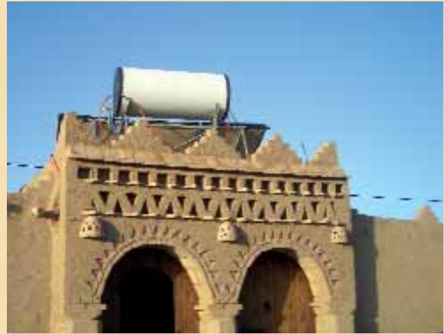
Installation de chauffe-eau solaire monobloc Source : CDER.
