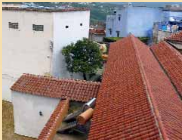
Installation solaire thermique individuelle dans l'habitat.
