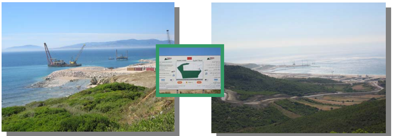
Vues générales du chantier de la TMSA
